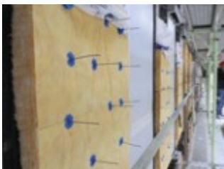
Ausführungsbeispiel: Luftschichtanker
