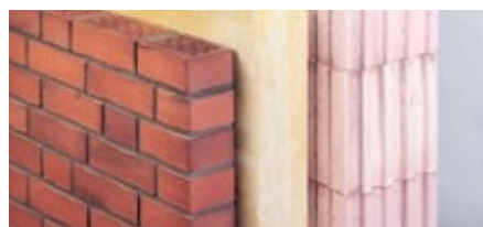
Prinzip Ausführung: Außenschale, Dämmung, Innenschale
