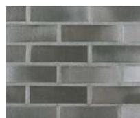
▲ Halbversetzter Läuferverband
